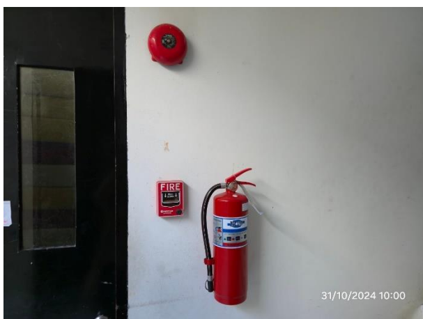
รูปที่ 17 อุปกรณ์ส่งสัญญาณเกิดเหตุเพลิงไหม้ภายในโครงการ
